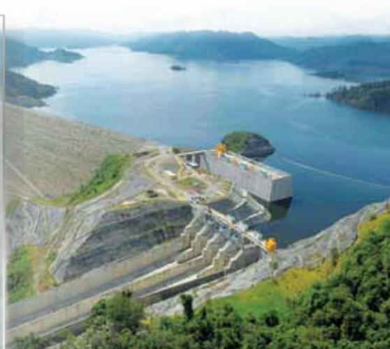
Gambar foto 6.3 Empangan hidro di Bakun, Sarawak
