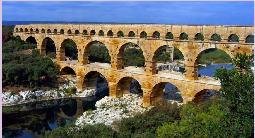
Akueduk di Pont Du Gard, Perancis.
