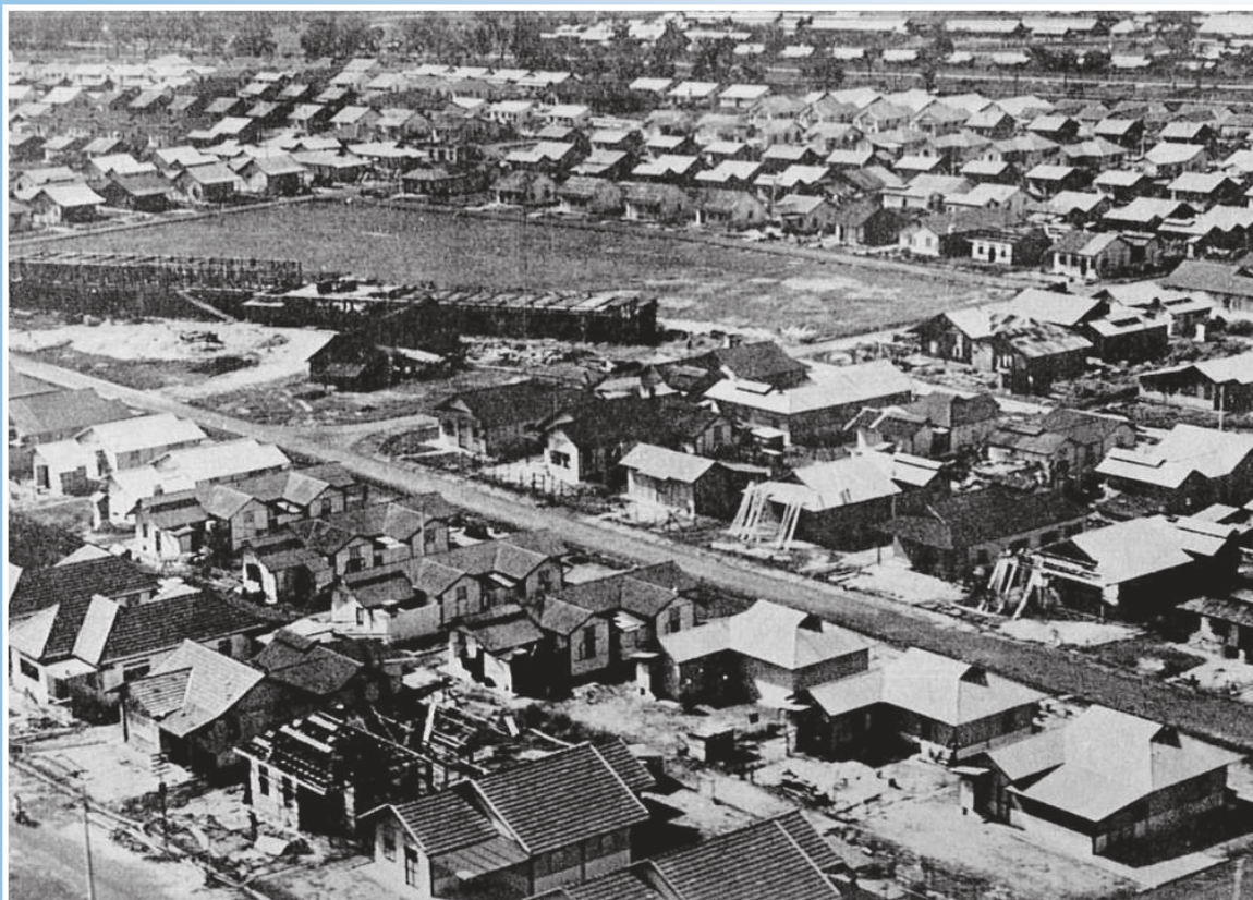
Pembinaan perumahan di Petaling Jaya, Selangor pada tahun 1950-an.
